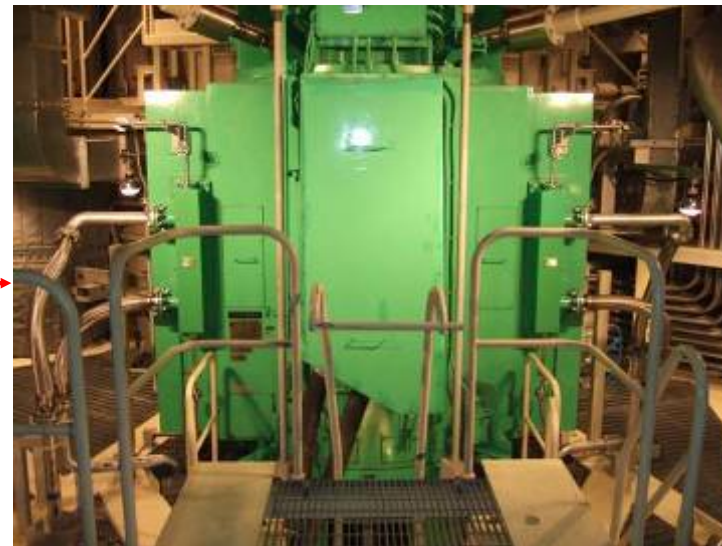
原子炉建屋B3F D/W内（PLRポンプ）
