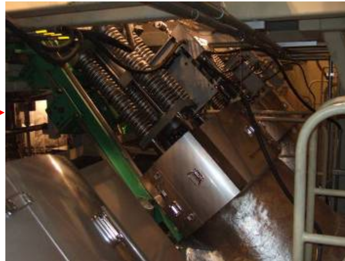
原子炉建屋B3F D/W内（PLRポンプ）
