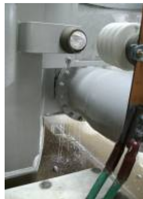
主変圧器下部油配管 (油漏れ)
