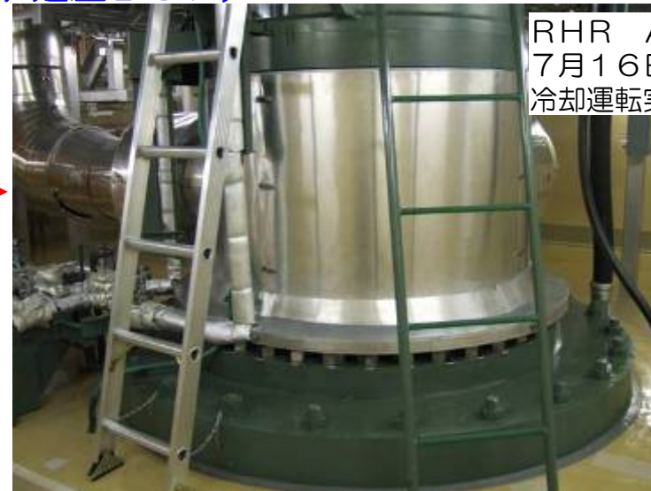
RHRポンプ (原子炉建屋B 5 F)
