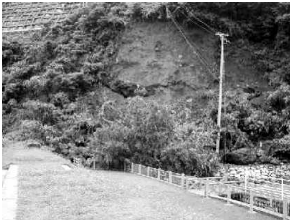
柏崎サケ種苗生産施設崖崩れ（柏崎市）
