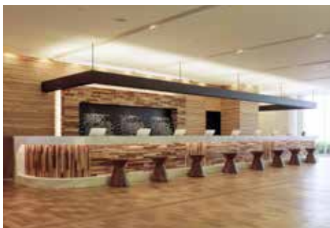
●ケース1の例 ホテルのフロントの内壁に不燃処理木材（樹脂注入）を使用（アワーズイン阪急シングル館）
