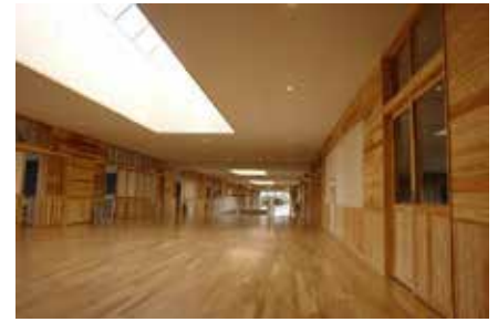
学校は内装制限の対象外になる (滝沢市立滝沢中央小学校)
