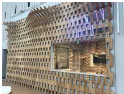
●ケース1の例 商業施設内のスタジオの内壁に不燃処理木材を使用（PRISM TV STUDIO [プリズム]）
