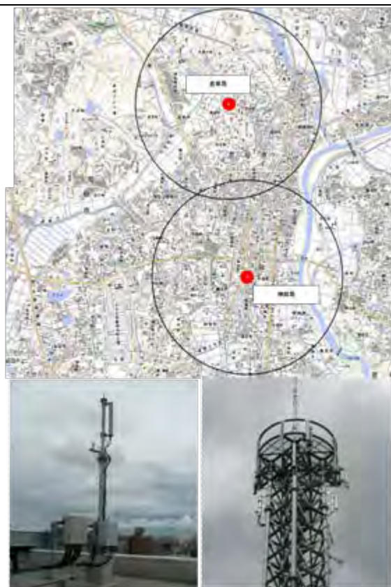
基地局設置状況事例（豊田市神田局、若草局）
