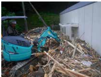
坂本ビル入口を塞ぐ流木等の撤去作業
