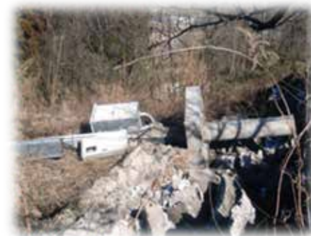
土砂崩れにより倒壊した携帯電話基地局 (写真 ソフトバンクモバイル(当時))
