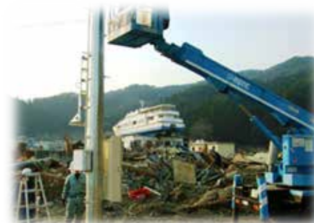
被災した携帯電話基地局の復旧 (写真 ソフトバンクモバイル(当時))
