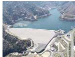
大分川ダム建設工事
