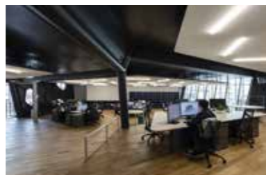
ワークスペースのインテリアには、柱・梁のみならず、スラブ(床)も鉄でつくられていることが現れます。
