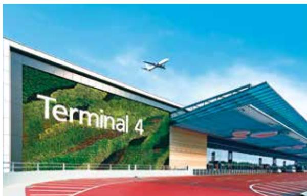
チャンギ空港 第4ターミナルビル (2017 シンガポール)
