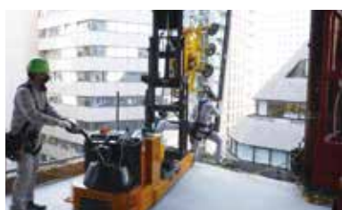
「カーテンウォーカーEV」(外装材取付機)
