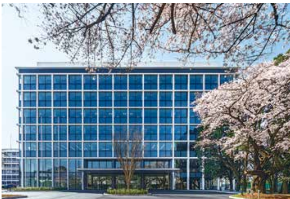
「理」と「和」を表現する格子フィンによる外装で、最適な採光環境と日射負荷抑制を図っています。
