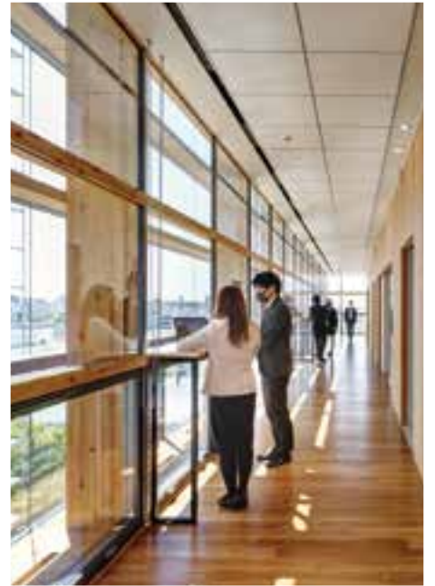
CLTパネルによる壁とスリムな木質部材の外装による、木のぬくもりと開放感のあるホワイエ。
