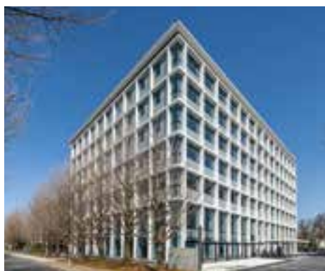
「理」と「和」を表現する格子フィンによる外装で、最適な採光環境と日射負荷抑制を図っています。
