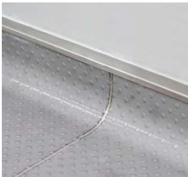
端部を20Rに折曲げした幅木を採用。 ゴミ溜まりが無く、洗浄が大変容易です。
