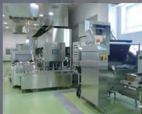
学校給食センター/連続炊飯システム
