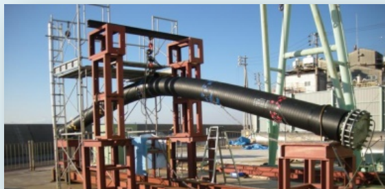
EF接合による一体化管路が可能 生曲げ配管より曲管数を削減可能
