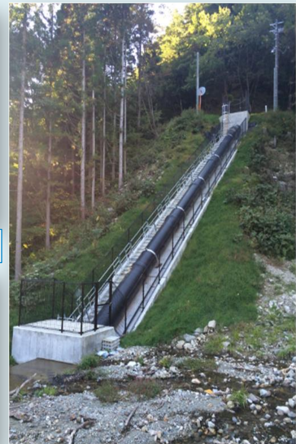
継手部の抜け出し・漏水なし
