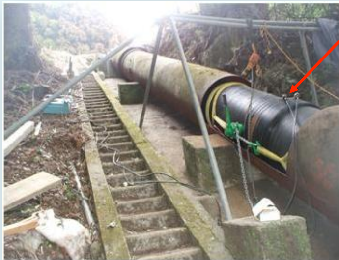
鋼管の管更生 パイプINパイプ
