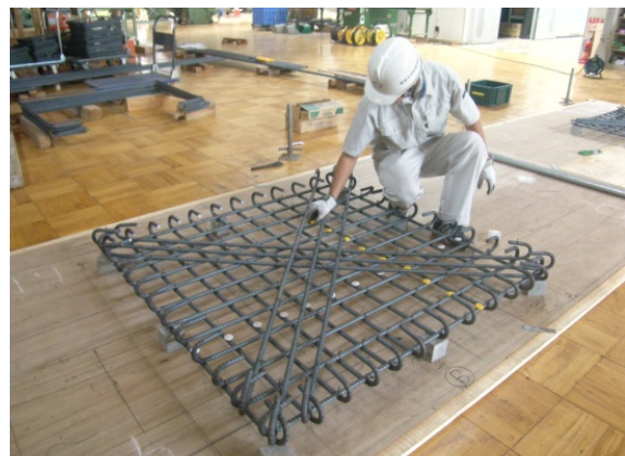
写真1 F2 ベース配筋
