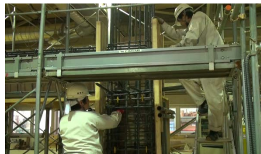
写真4 上部実寸大モデルの配筋状況
