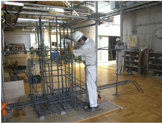
写真2 下部実寸大モデルの配筋状況
