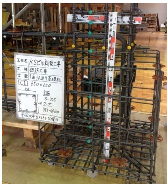
写真8 C1基礎柱配筋写真
