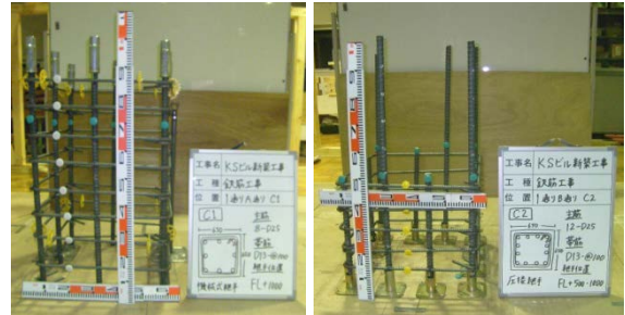
写真3 継手部分配筋写真(左C1、右C2)
