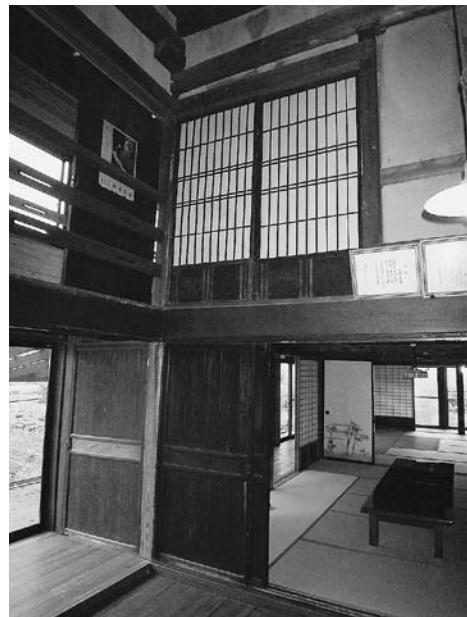
写真 3-6 高屋敷二階の出し入れ口
