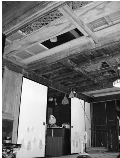
写真 3-7 空気循環のためのオカミ天井開口部（高屋敷）
