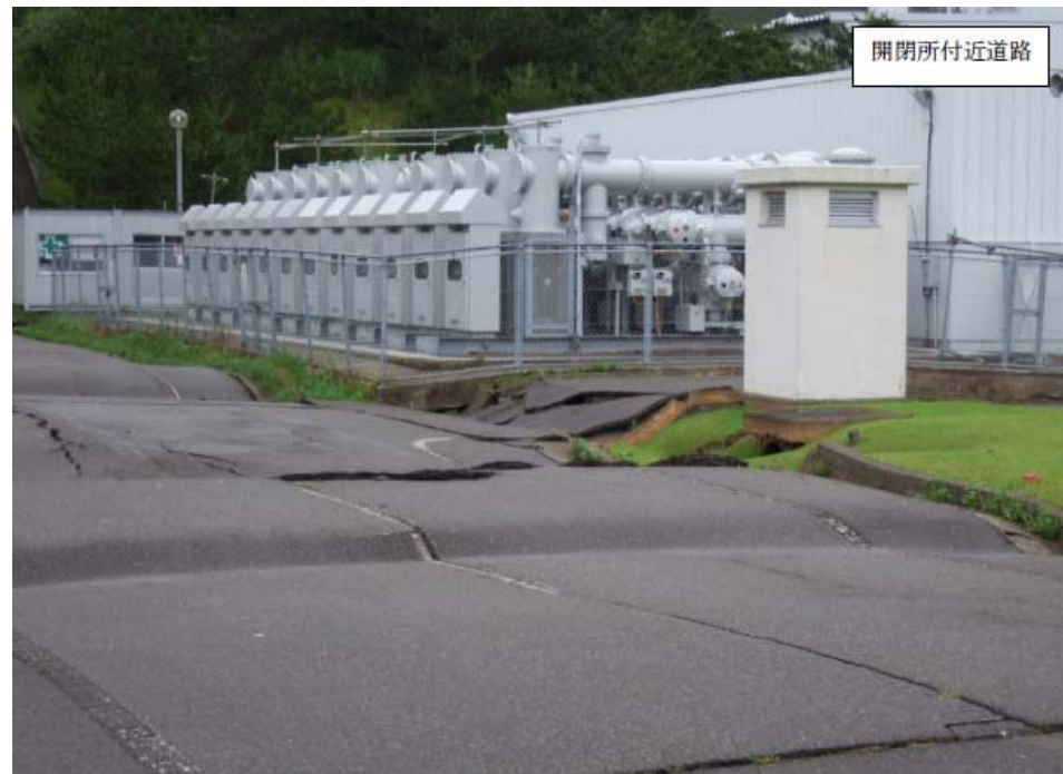
構内道路の被害例（5号機放水口付近道路）
