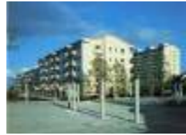
シティ能見台ふれあいの街 顧客：熊谷組(株) 所在地：神奈川県 延床面積：68,190㎡ 規模：B1F~10F 竣工：1993年 住戸数：624戸
