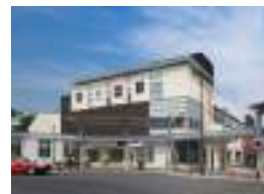
武蔵小山駅ビル 顧客：東京急行電鉄(株) 所在地：東京都 延床面積：7,214㎡ 規模：B1F~4F 竣工：2010年
