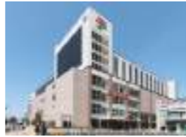
イトーヨーカ堂武蔵小金井店 顧客：(株)イトーヨーカ堂 所在地：東京都 延床面積：54,970㎡ 規模：B1F~7F 竣工：2009年
