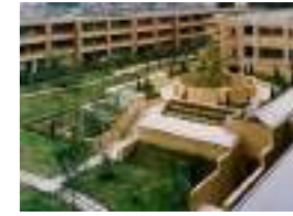
ガーデンズパッパ武蔵野の杜 顧客：有楽土地(株)、日鉄ライフ(株) 所在地：東京都 延床面積：24,563㎡ 規模：B2F~8F 竣工：2001年 住戸数：259戸
