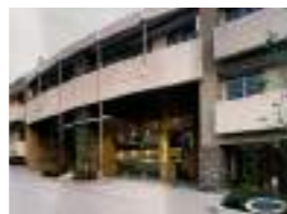
フェアロージュ南平台 顧客：新日本製鐵(株) 所在地：東京都 延床面積：B1F~4F 竣工：2000年 住戸数：32戸
