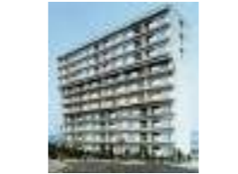
東急鷺沼スカイドエリング 顧客：東京急行電鉄(株) 所在地：神奈川県 延床面積：7,572㎡ 規模：10F 竣工：1970年 住戸数：97戸
