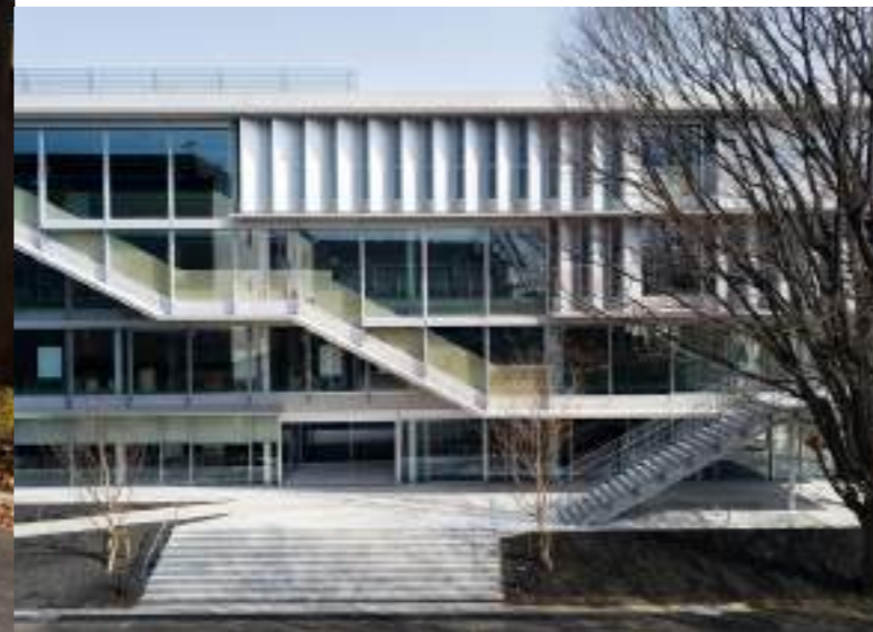
上/1号館、下/7号館
