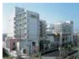
堀東急ビル西棟・東棟 顧客：東急不動産(株) 所在地：大阪府 延床面積：8,000㎡ 規模：7F、5F 竣工：西棟1990年、 東棟1991年
