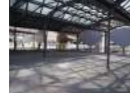
渋谷ストリーム 国道246デッキ 顧客：東京急行電鉄(株) 所在地：東京都 業務内容：鉄道橋を再利用した 歩行者デッキ設計 竣工：2018年
