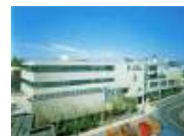
創価学会城西会館 顧客: 大京観光(株) 所在地: 東京都 延床面積: 7,470㎡ 規模: B1F~4F 竣工: 1988年
