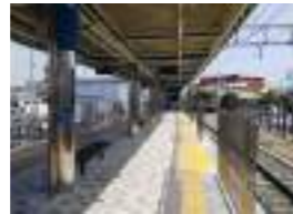
遠州鉄道浜北駅 顧客：遠州鉄道(株) 所在地：静岡県 業務内容：ホームバリアフリー 改修設計 竣工：2018年
