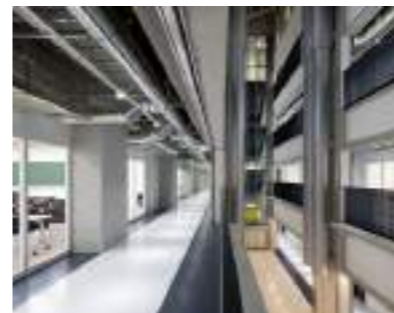
共用廊下と吹抜(1号館)
