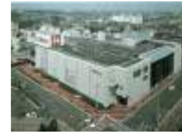
東急ストア中央林間店 顧客: 東京急行電鉄(株) 所在地: 神奈川県 延床面積: 23,118㎡ 規模: B1F~3F 竣工: 1985年
