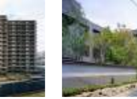
プレステージ浜田山ガーデンズ 顧客：東急不動産(株) 所在地：東京都 延床面積：4,392㎡ 規模：B1F~3F 竣工：1997年 住戸数：50戸
