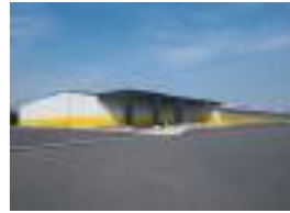
アドヴァン岩井倉庫 顧客：アドヴァン管理サービス(株) 所在地：茨城県 延床面積：7,600㎡ 規模：1F 竣工：2014年
