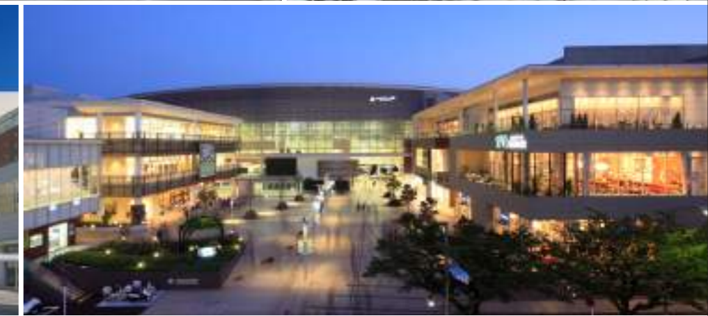
上/たまプラーザ駅改札および同改札前広場から望む大屋根 下左/南口交通広場側から北側を見通す 下右/まちを南北につなぐ自由通路と北口「ステーションコート」
