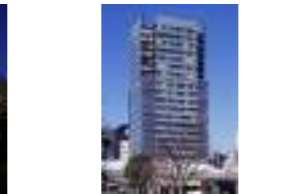
浜松町スクエア 顧客：東急不動産(株) 所在地：東京都 延床面積：23,947㎡ 規模：B1F～20F 竣工：2004年
