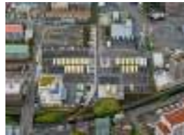
神奈川中央交通茅ヶ崎営業所建替計画敷地造成 顧客：(株)神奈川中央交通 所在地：神奈川県 開発面積：1.4ha 竣工：2022年
