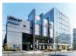
イエローハット目黒青葉台ビル 顧客：(株)イエローハット 所在地：東京都 延床面積：18,962㎡ 規模：B2F~7F 竣工：2000年
