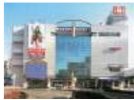
中山駅前再開発 顧客：(株)東急ストア、 永和不動産(株) 所在地：神奈川県 延床面積：19,000㎡ 規模：B1F~6F、B1F~5F 竣工：1991年
