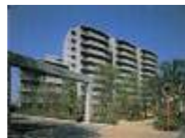
イトーピア網島コンドミニアム 顧客：伊藤忠不動産(株) 所在地：神奈川県 延床面積：19,260㎡ 規模：B1F~14F 竣工：1990年 住戸数：168戸
