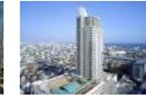
アスタくづか三番館 顧客：神戸市 所在地：兵庫県 延床面積：57,343㎡ 規模：B1F～29F 竣工：2004年
