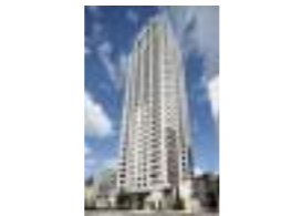
プランズタワー南堀江 顧客：東急不動産(株) 所在地：大阪府 延床面積：17,413㎡ 規模：B1F～25F 竣工：2014年 住戸数：230戸
