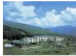
裏磐梯デコ平ホテル・スキーセンター 顧客：東京急行電鉄(株) 所在地：福島県 延床面積：ホテル13,000㎡、 スキーセンター11,000㎡ 規模：ホテルB1F~4F、 スキーセンターB1F~2F 竣工：1990年 客室数：102室
