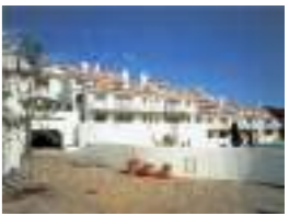
コスモスロズ返子 顧客：(株)リクルートコスモス 所在地：神奈川県 延床面積：17,320㎡ 規模：B2F~3F 竣工：1991年 住戸数：100戸
