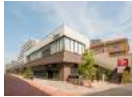
エミナード石神井公園 顧客：西武鉄道(株) 所在地：東京都 延床面積：5,441㎡ 規模：2F 竣工：2017年
