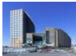
二子玉川ライズ ショッピングセンター&オフィス 顧客：二子玉川東地区市街地再開発組合 所在地：東京都 延床面積：106,700㎡ 規模：B2F~16F 竣工：2011年
