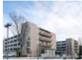
サンクタスシティ長津田みなみ台レジデンス 顧客：オリックス不動産(株) 所在地：神奈川県 延床面積：20,984㎡ 規模：5F 竣工：2013年 住戸数：205戸
