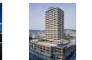
アスタプラザウェスト 顧客：(株)環境再開発研究所 所在地：兵庫県 延床面積：37,435㎡ 規模：B1F～26F 竣工：2005年 住戸数：126戸
