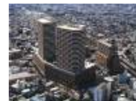
フェスタ立花 顧客：(株)環境再開発研究所 所在地：兵庫県 延床面積：81,360㎡ 規模：B1F~27F 竣工：2000年 住戸数：359戸
