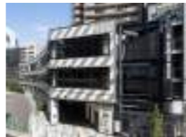
渋谷ブリッジ 顧客：東急(株) 所在地：東京都 延床面積：5,642㎡ 規模：6F 竣工：2018年
