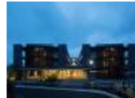
こまへ正吉苑二番館 顧客：(福)正吉福祉会 所在地：東京都 延床面積：5,948㎡ 規模：3F 竣工：2014年 病床数：特養100床/ショート10床
