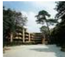
東急ドエルアルス弦巻 顧客：東急不動産(株) 所在地：東京都 延床面積：12,040㎡ 規模：5F 竣工：1979年 住戸数：126戸
