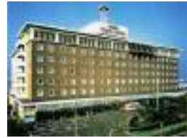
羽田東急ホテル 顧客：(株)羽田東急ホテル 所在地：東京都 延床面積：10,358㎡ 規模：B2F~8F 竣工：1964年 客室数：60室
