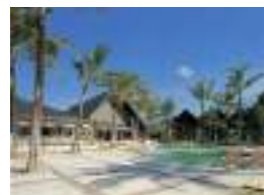
パラオバシフィックリゾート 顧客: パシフィックアイランズ デベロップメント 所在地: ペラウ共和国 延床面積: 10,480㎡ 規模: 2F 竣工: 1984年 客室数: 150室
