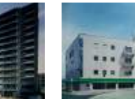
馬込沢ランドショッピングセンター 顧客：レランドミヤザキ(株) 所在地：千葉県 延床面積：17,157㎡ 規模：B2F~5F 竣工：1998年
