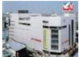
大井町K-1ビル 顧客：かんべ土地建物(株) 所在地：東京都 延床面積：37,947㎡ 規模：B4F~7F 竣工：1997年
