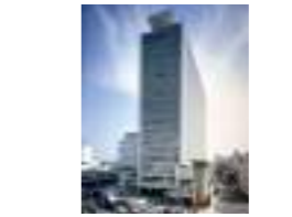
JR東急目黒ビル 顧客：東京急行電鉄(株)、東日本旅客鉄道(株) 所在地：東京都 延床面積：52,221㎡ 規模：B4F~17F 竣工：2002年
