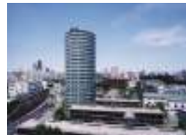
ドレッセ目黒インプレスタワー 顧客：東京急行電鉄(株) 所在地：東京都 延床面積：13,122㎡ 規模：B1F～23F 竣工：2004年 住戸数：129戸
