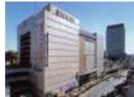
上大岡駅前再開発ビル(構造) 顧客：京浜急行電鉄(株) 所在地：神奈川県 延床面積：99,000㎡ 規模：B3F~11F 竣工：1996年
