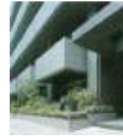
東京機械製作所本社ビル 顧客: (株)東京機械製作所 所在地: 東京都 延床面積: 7,365㎡ 規模: B1F~6F 竣工: 1985年
