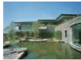
東急セブンハンドレッドクラブ C.H 顧客：東京急行電鉄(株) 所在地：千葉県 延床面積：9,110㎡ 規模：2F 竣工：1989年
