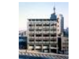
警視庁大森警察署 顧客：警視庁 所在地：東京都 延床面積：7,568㎡ 規模：B1F~8F 竣工：2002年
