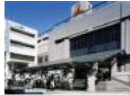
横浜市高速鉄道日吉駅改修 顧客：東京急行電鉄(株) 所在地：神奈川県 延床面積：38,316㎡ 規模：B1F~6F 竣工：2009年
