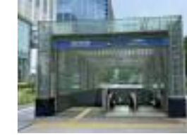
新高島駅ESC設置 顧客：横浜高速鉄道(株) 所在地：神奈川県 業務内容：エスカレーター設置 設計 竣工：2020年
