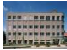
昭島市保健福祉センター「あいぼっく」 顧客：昭島市 所在地：東京都 延床面積：6,170㎡ 規模：B1F~4F 竣工：2001年
