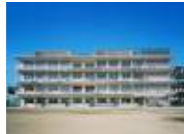
園田小学校北棟改築 顧客：尼崎市 所在地：兵庫県 延床面積：3,791㎡ 規模：4F 竣工：2016年
