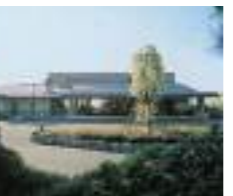
稲取ゴルフ場C.H 顧客：伊豆急行(株) 所在地：静岡県 延床面積：4,100㎡ 規模：2F 竣工：1990年
