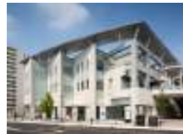
狭山市市民交流センター(スカイテラス) 顧客：(独)都市再生機構 所在地：埼玉県 延床面積：5,642㎡ 規模：3F 竣工：2012年
