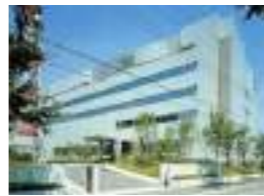
ライフ東京総合センター 顧客：東京急行電鉄(株) 所在地：神奈川県 延床面積：16,980㎡ 規模：B1F~5F 竣工：1991年
