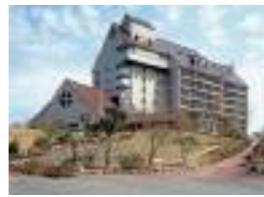
ハーヴェストクラブ天城高原 顧客：東急不動産(株) 所在地：静岡県 延床面積：12,645㎡ 規模：B1F~8F 竣工：1991年 客室数：120室
