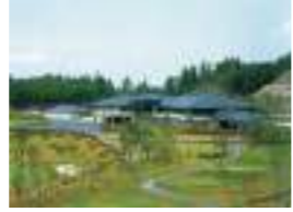
有田東急ゴルフ場C.H. 顧客：東急不動産(株) 所在地：和歌山県 延床面積：3,433㎡ 規模：2F 竣工：1994年
