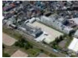
小田急バス登戸営業所敷地造成 顧客：小田急バス(株) 所在地：神奈川県 開発面積：1.0ha 竣工：2013年
