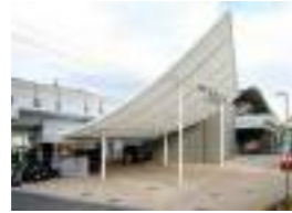
京王よみうりランド駅リニューアル 顧客：京王電鉄(株) 所在地：東京都 延床面積：296㎡ 規模：2F 竣工：2018年
