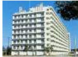
東急ドエル藤澤フェニックス 顧客：東急不動産(株) 所在地：神奈川県 延床面積：14,451㎡ 規模：10F 竣工：1969年 住戸数：200戸
