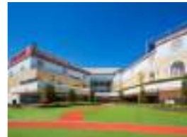
セブンパークアリオ柏 顧客：(株)イトーヨーカ堂 所在地：千葉県 延床面積：137,149㎡ 規模：3F 竣工：2016年
