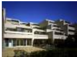
ドレッセ田園調布プレザンス 顧客：東京急行電鉄(株) 所在地：東京都 延床面積：7,504㎡ 規模：B2F～3F 竣工：2004年 住戸数：34戸
