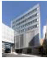
新静岡B棟静鉄鷹匠ビル、C棟鷹匠駐輪場 顧客：静岡鉄道(株) 所在地：静岡県 延床面積：7,477㎡ 規模：B1F~6F 竣工：2011年
