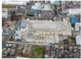
神奈川中央交通秦野営業所建替計画敷地造成 顧客：(株)神奈川中央交通 所在地：神奈川県 開発面積：2.6ha 竣工：2020年
