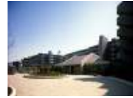
オーベルグランディオ上大岡 顧客：有楽土地(株) 所在地：神奈川県 延床面積：38,524㎡ 規模：B1F~7F 竣工：1999年 住戸数：346戸
