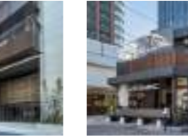
こすぎコアパーク 顧客：東急(株) 所在地：神奈川県 延床面積：277㎡ 規模：2F 竣工：2021年
