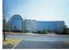
土気あすみが丘プラザ 顧客：東急不動産(株) 所在地：千葉県 延床面積：4,590㎡ 規模：B1F~4F 竣工：1993年
