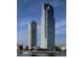
聖路加レジデンス棟(内装設備) 顧客：三井不動産(株)、東急不動産(株)他 所在地：東京都 延床面積：42,000㎡ 規模：B4F~38F 竣工：1994年 客室数：ケアレジデンス225室、新阪急ホテル100室
