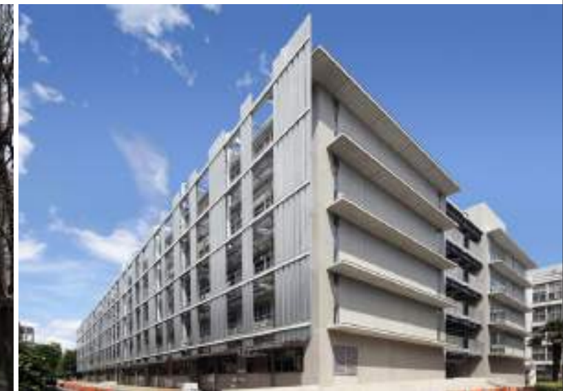
上/6号館、下/10号館
