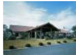
ファイブハンドレッドC.H. 顧客：東京急行電鉄(株) 所在地：静岡県 延床面積：1,933㎡ 規模：B1F~2F 竣工：1980年
