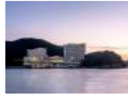
ハンパホテル&リゾート ベルベドール 顧客：Gansam Architects & Pa 所在地：韓国 延床面積：97,000㎡ 規模：17F 竣工：2017年 客室数：565室
