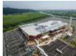
三井アウトレットパーク北陸小矢部 顧客：三井不動産(株) 所在地：富山県 延床面積：42,526㎡ 規模：2F 竣工：2016年
