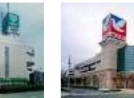
イトヨーカ堂白井店 顧客：東急不動産(株) 所在地：千葉県 延床面積：40,507㎡ 規模：5F 竣工：1998年
