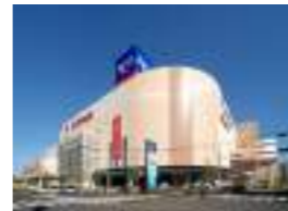
アリオ西新井 顧客：(株)イトーヨーカ堂 所在地：東京都 延床面積：107,982㎡ 規模：B1F～6F 竣工：2007年
