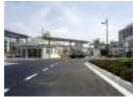
武蔵小山駅改良 顧客：東京急行電鉄(株) 所在地：東京都 延床面積：1,273㎡ 規模：B2F~1F 竣工：2009年
