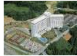
成田東急インII 顧客: 東急不動産(株) 所在地: 千葉県 延床面積: 37,000㎡ 規模: B2F~11F、12F 竣工: I期1985年、II期1993年 客室数: 712室
