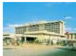
ショナルガオンホテル 顧客：(株)東急ホテルズ 所在地：神奈川県 延床面積：27,312㎡ 規模：8F 竣工：1981年 客室数：342室
