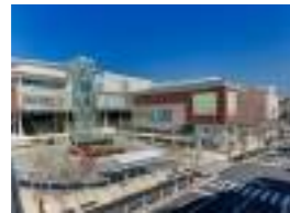
たまプラーザテラスゲートプラザ 顧客：東京急行電鉄(株) 所在地：神奈川県 延床面積：87,872㎡ 規模：B2F~5F 竣工：2010年
