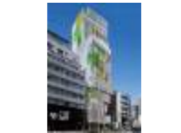
キューバラ原宿 顧客：東急不動産(株) 所在地：東京都 延床面積：13,300㎡ 規模：B2F～11F 竣工：2015年
