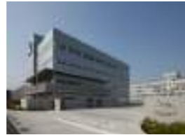
小田急バス登戸営業所 顧客：小田急バス(株) 所在地：神奈川県 延床面積：4,092㎡ 規模：4F 竣工：2013年
