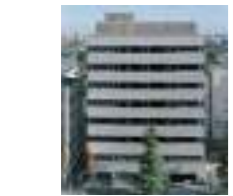
南平台ビル 顧客：(株)日交総本社 所在地：東京都 延床面積：4,514㎡ 規模：8F 竣工：1989年
