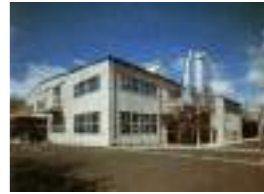
白木金属工業大阪工場 顧客：白木金属工業(株) 所在地：大阪府 延床面積：12,401㎡ 規模：2F 竣工：1977年
