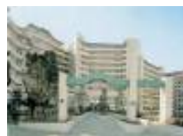
かしわ台集合住宅 顧客：相模鉄道(株) 所在地：神奈川県 延床面積：26,000㎡ 規模：11F 竣工：1990年 住戸数：260戸
