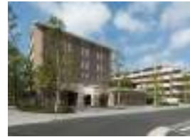
ドレッセ鷺沼の杜プライムフォレスト 顧客：東京急行電鉄(株) 所在地：神奈川県 延床面積：46,519㎡ 規模：B2F～6F 竣工：2013年 住戸数：389戸
