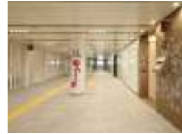
渋谷ちかみちラウンジ 顧客：東京急行電鉄(株) 所在地：東京都 延床面積：47,282㎡ 規模：B5F～1F 竣工：2014年
