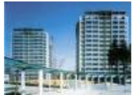
ガーデンシティ八千代 顧客：東洋不動産(株) 所在地：千葉県 延床面積：15,288㎡ 規模：14F 竣工：1996年 住戸数：167戸
