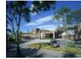
東急ハーヴェスクラブ旧軽井沢 顧客：東急不動産(株) 所在地：長野県 延床面積：16,023㎡ 規模：3F 竣工：2001年 客室数：156室
