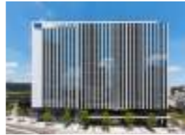
TKS武蔵小杉ビル 顧客：(株)東京機械製作所 所在地：神奈川県 延床面積：17,768㎡ 規模：B1F～11F 竣工：2013年
