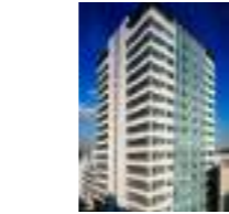
恵比寿ビジネスタワー 顧客：東急不動産(株) 所在地：東京都 延床面積：28,260㎡ 規模：18F 竣工：2003年
