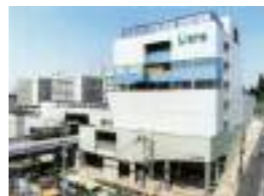
青葉台駅ビル 顧客：東京急行電鉄(株) 所在地：神奈川県 延床面積：18,300㎡ 規模：B1F~8F 竣工：1992年
