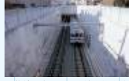
目蒲線千束~目黒連続立体交差
