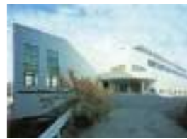
東京工業大学体育館 顧客：東京急行電鉄(株) 所在地：東京都 延床面積：4,814㎡ 規模：B1F~3F 竣工：1991年
