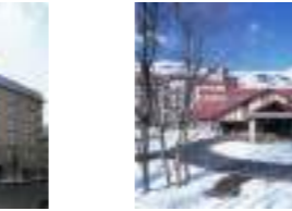
白馬東急ホテル 顧客：東急ホテルチェーン(株) 所在地：長野県 延床面積：10,386㎡ 規模：B1F~5F 竣工：1997年 客室数：100室
