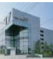
東急ケーブルテレビ 放送センター 顧客: 東京急行電鉄(株) 所在地: 神奈川県 延床面積: 3,065㎡ 規模: 4F 竣工: 1987年
