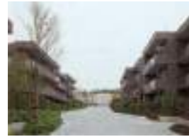
藤和ライブタウン下永谷 顧客：藤和不動産(株) 所在地：神奈川県 延床面積：24,710㎡ 規模：3F 竣工：1993年 住戸数：205戸
