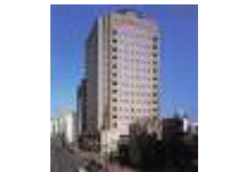
ニューサテライトホテル芝浦 顧客：(株)サテライト不動産、(株)日交サテライト 所在地：東京都 延床面積：15,450㎡ 規模：B2F~14F 竣工：1995年 客室数：160室
