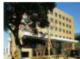
品川勤労福祉会館+分庁舎 顧客：品川区 所在地：東京都 延床面積：10,230㎡ 規模：B1F~7F 竣工：1980年
