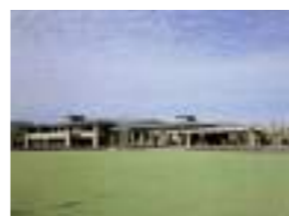
季美の森ゴルフクラブC.H 顧客：東急不動産(株) 所在地：千葉県 延床面積：3,940㎡ 規模：2F 竣工：1993年
