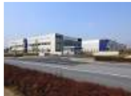
TKSがざさテクノセンター 顧客：(株)東京機械製作所 所在地：千葉県 延床面積：20,867㎡ 規模：2F 竣工：2011年
