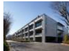
東京都市大学1号館 顧客：(学)五島育英会 所在地：東京都 延床面積：14,988㎡ 規模：B1F～4F 竣工：2013年
