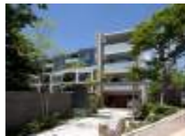
ブランズ田園調布 顧客：東急不動産(株) 所在地：東京都 延床面積：6,359㎡ 規模：B2F~5F 竣工：2012年 住戸数：52戸
