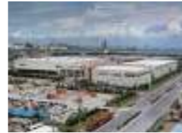
東扇島流通センター 顧客: (株)東急ストア 所在地: 神奈川県 延床面積: 30,000㎡ 規模: 2F 竣工: I期1985年、II期1988年
