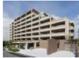
ブランズ千里桃山台 顧客：東急不動産(株) 所在地：東京都 延床面積：8,046㎡ 規模：B1F~8F 竣工：2011年 住戸数：83戸
