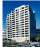
東急ドエルアルス鷺沼ネクステージ 顧客：東急不動産(株) 所在地：神奈川県 延床面積：7,850㎡ 規模：14F 竣工：1999年 住戸数：78戸
