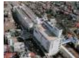
町田ターミナルプラザ (東急ハンズ) 顧客: 東京急行電鉄(株) 所在地: 東京都 延床面積: 20,310㎡ 規模: B2F~8F 竣工: 1983年
