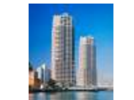
キャナルワフタワーズ 顧客：東急不動産(株)、新日本製鐵(株) 所在地：東京都 延床面積：72,791㎡ 規模：B1F~36F 竣工：2000年 住戸数：498戸
