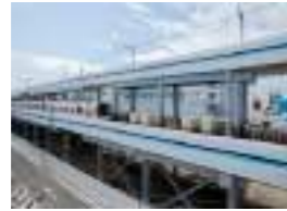
京急蒲田駅付近連続立体交差 顧客：京浜急行電鉄(株) 所在地：東京都 業務内容：鉄道高架橋設計 竣工：2012年
