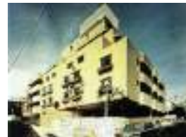
東急アパート代官山タワー 顧客：東急不動産(株) 所在地：東京都 延床面積：6,451㎡ 規模：B1F~6F 竣工：1971年 住戸数：26戸
