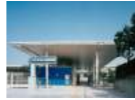
相鉄線南万騎が原駅改良 顧客：相模鉄道(株) 所在地：神奈川県 延床面積：868㎡ 規模：2F 竣工：2000年
