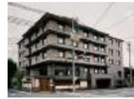
ビッグウィーク京都 顧客：東京急行電鉄(株) 所在地：京都府 延床面積：2,497㎡ 規模：5F 竣工：1999年 客室数：21室
