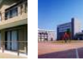
東京都市大学横浜キャンパス 顧客：(学)五島育英会 所在地：神奈川県 延床面積：2,059㎡/2,075㎡ 規模：B1F~6F 竣工：1997年
