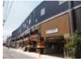
東横線祐天寺駅改良 顧客：東京急行電鉄(株) 所在地：東京都 延床面積：558㎡ 規模：1F 竣工：2017年
