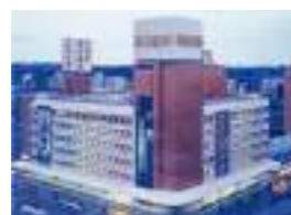
江ノ電百貨店 顧客：江ノ島鎌倉観光(株) 所在地：神奈川県 延床面積：31,225㎡ 規模：B2F~7F 竣工：1974年
