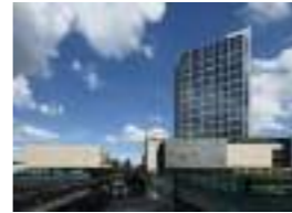
二子玉川エクセルホテル東急 顧客：二子玉川東地区市街地再開発組合 所在地：東京都 延床面積：157,000㎡ 規模：B2F～30F 竣工：2015年 客室数：109室
