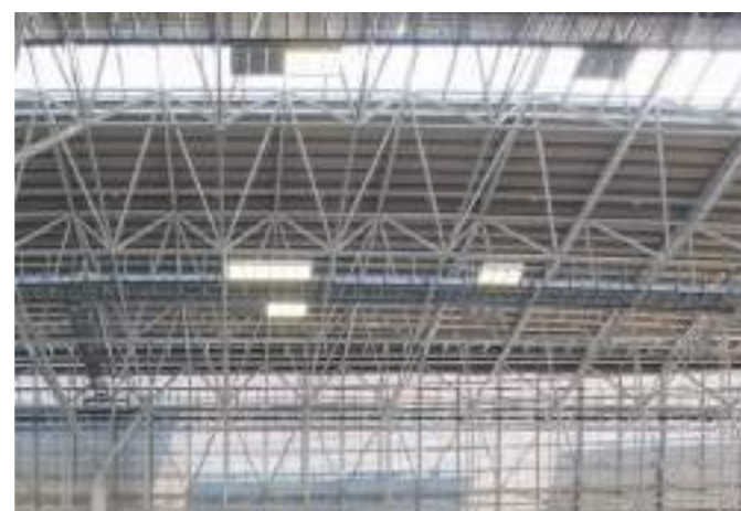
立体トラス構造の大屋根
