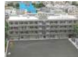
品川区立第二延山小学校 顧客：品川区 所在地：東京都 延床面積：9,204㎡ 規模：4F 竣工：2007年
