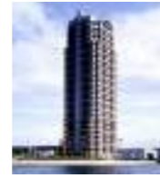
辰巳ベルタワー 顧客：東邦港運(株) 所在地：東京都 延床面積：22,783㎡ 規模：B1F~32F 竣工：1999年 住戸数：209戸
