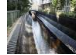
渋谷ストリーム 壁泉 顧客：東京急行電鉄(株) 所在地：東京都 業務内容：清流復活水河川放流 施設設計 竣工：2018年
