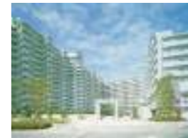
東急ドエルアルス多摩川 顧客: 東急不動産(株) 所在地: 東京都 延床面積: 41,150㎡ 規模: 14F 竣工: 1987年 住戸数: 461戸
