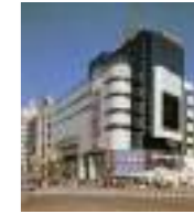
109-② 顧客: 東京急行電鉄(株) 所在地: 東京都 延床面積: 10,776㎡ 規模: B3F~9F 竣工: I期1985年、II期1987年
