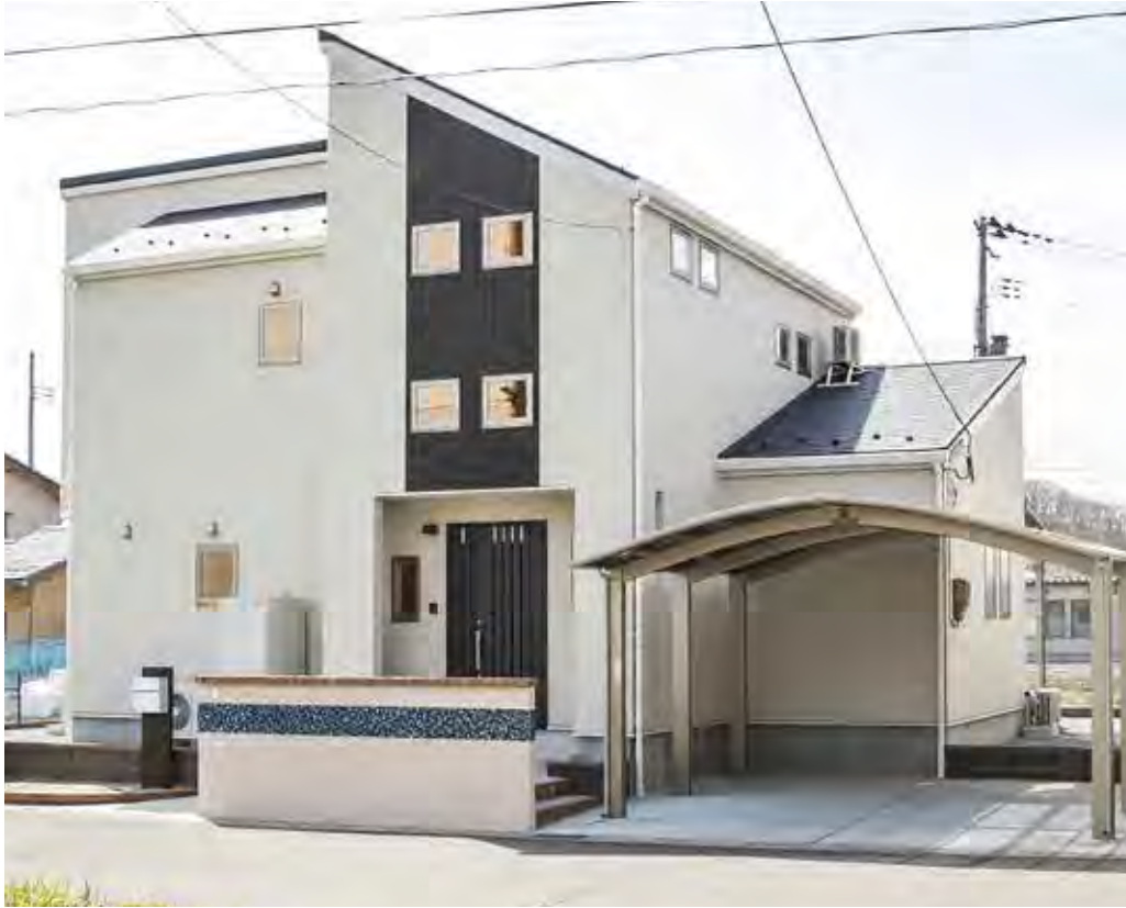
スクエア調の外壁に木目調の縦ライン、シルバーサッシを採用したモダンな外観。窓ガラスは外から見えないLow-Eガラス。家づくりとあわせて外構やカーポートも杜和建設に依頼することでトータルで美しい外観が完成。外構のガラスモザイクタイルのブルーは、息子さんが選んだ
