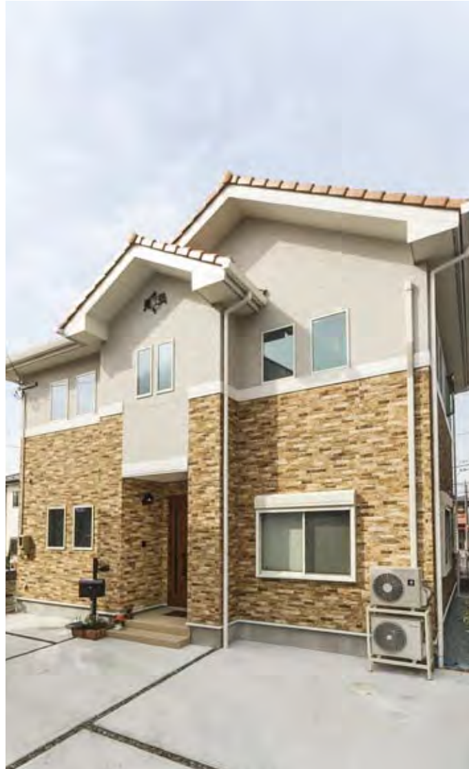
外観は実物を見て選んだレンガ調の外壁を採用。縁起のいいフクロウの妻飾りがO邸のシンボル。ロマンチックなものが好きな妻が「一度は自分好みの家建てたい」と憧れを叶えた家だ
