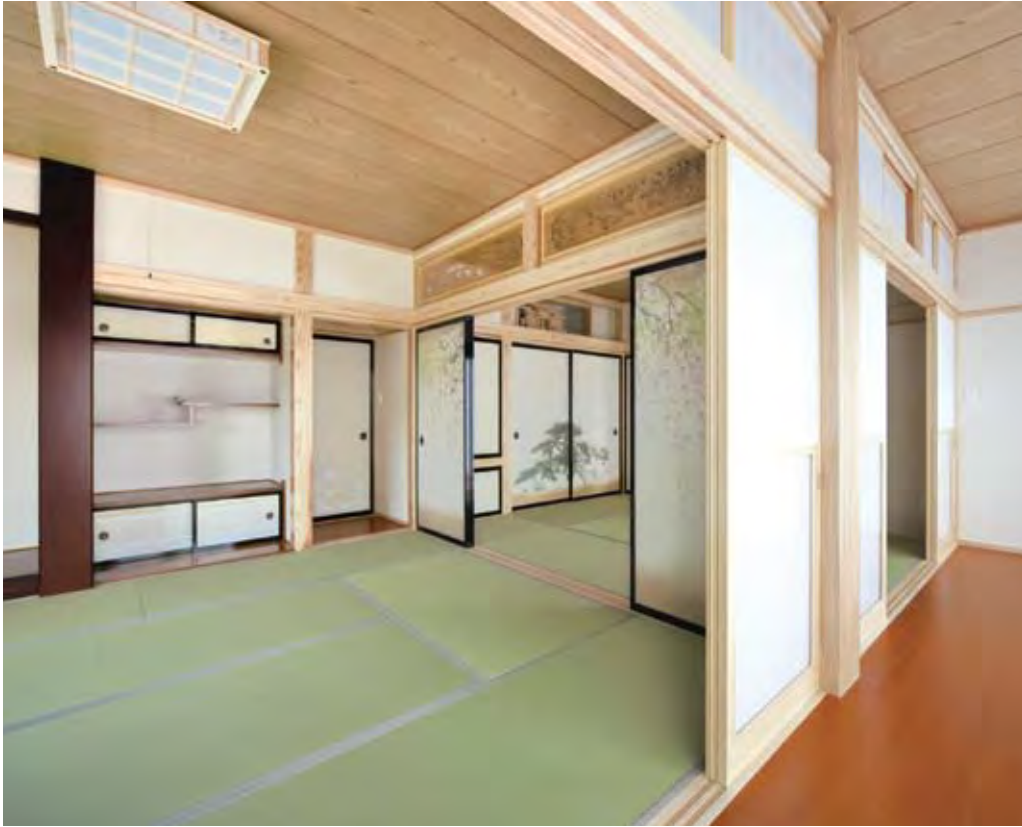
七寸角の大黒柱、細やかな細工の欄間や床の間・床脇、雪見障子、広縁と、和の意匠に満ちた2間続きの和室。どの部屋も採光にこだわったK様宅は、外張断熱、壁倍率5倍と耐震性にも配慮され長期優良住宅の性能基準をクリアした、末永い暮らしを見据えた住まいである
