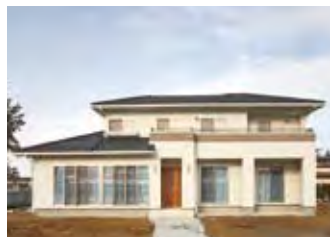
住まいの外観も明るいものと、白を選択。継ぎ目の無いシーリングレスの外壁が美しい
