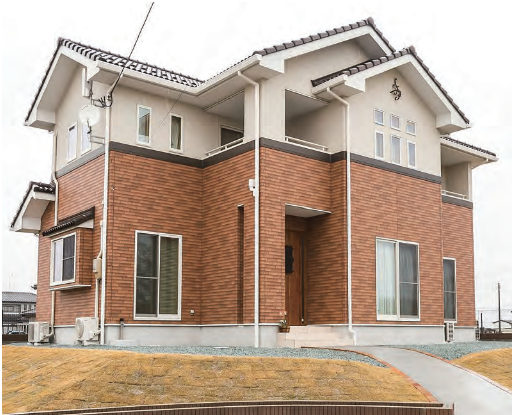
同社の展示場を見てWさんがひとめ惚れした外観デザインを参考にコーディネートした洋風の外観。正面は切妻屋根が重なり、斜めから見ると凹凸がある変化に富んだフォルム。妻飾りと玄関ドアの飾りと取っ手はアイアン製で統一、窓の形やサッシの色も揃え、可愛い印象だ
