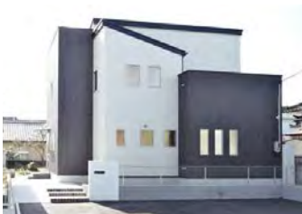
深い色の木調とホワイトのカラーリングで縦のラインを強調しモダンさを演出した外観
