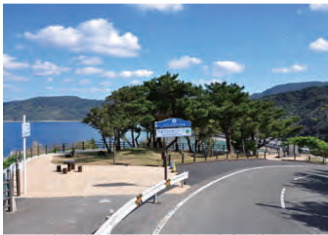
主要地方道名瀬瀬戸内線・大金久地区
