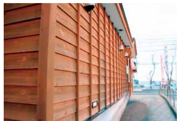
押さえ棧をつけた場合の施工例
