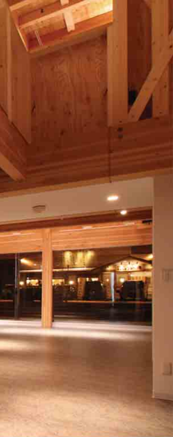
1階はラーメン構造、2階は在来軸組工法。2つの構造の差異を一目で感じられる空間
