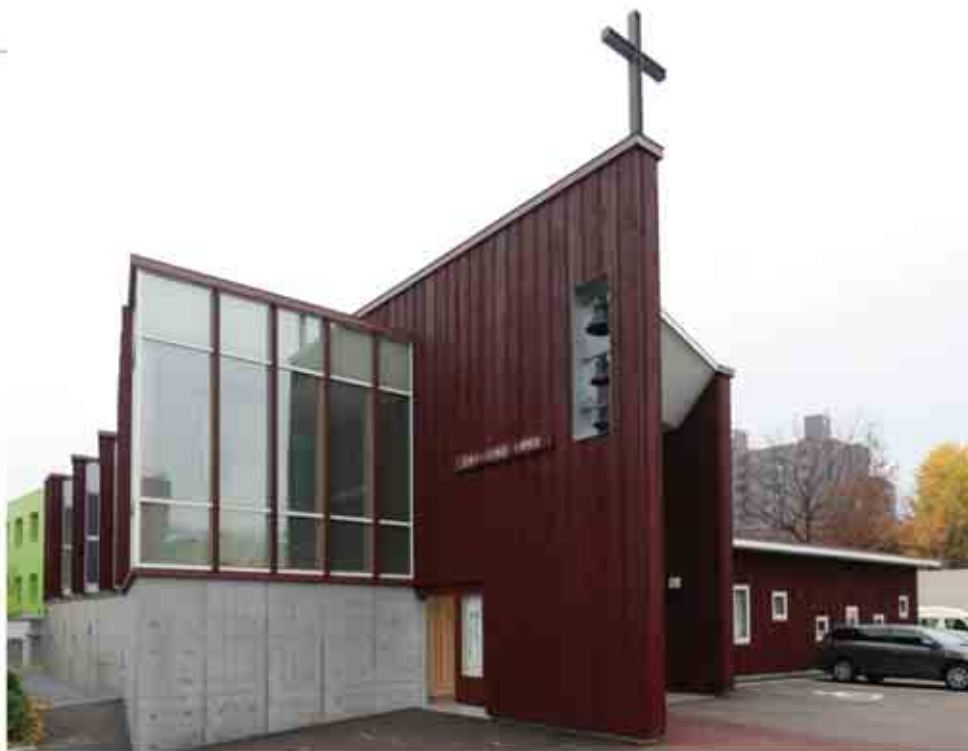
小樽教会外観：外壁カラマツ荒挽板18mm厚 大和張
