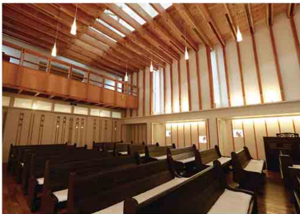
礼拝堂2階ギャラリー側： 1階2.3mはRC造、内部仕上材としてカラマツ構造用合板や三層合板を現しで使用
