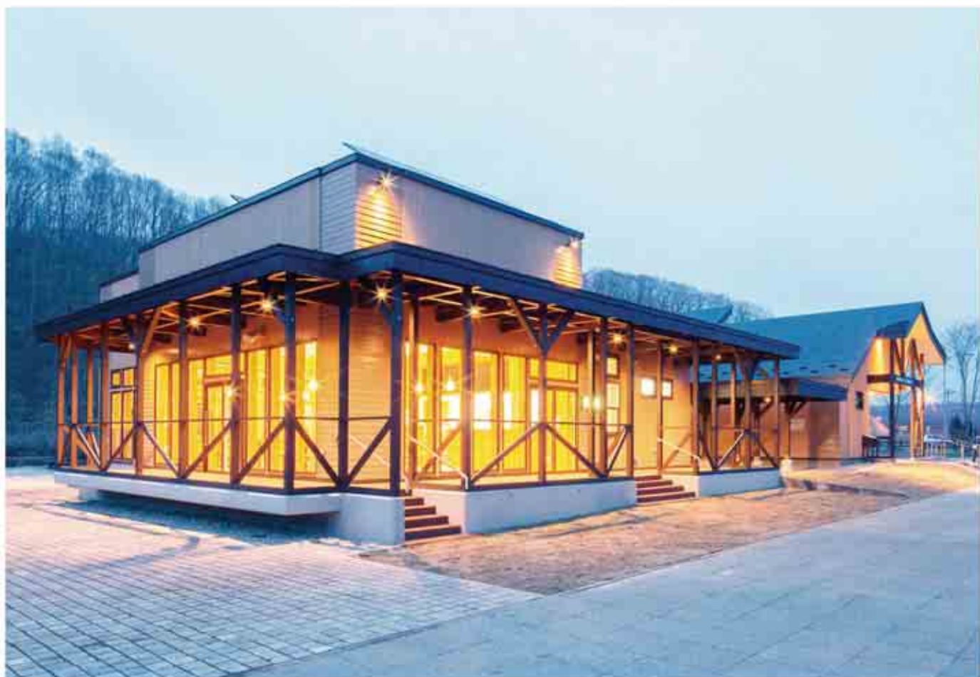
レストラン棟外観（外壁は木材・プラスチック再生複合材を使用し耐久性と木質景観に配慮）
