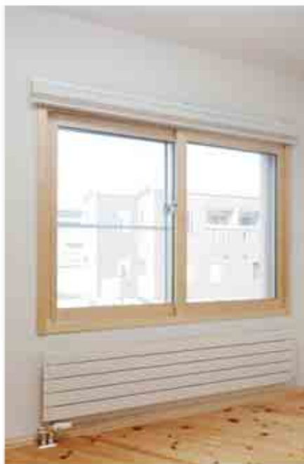
ペアガラスを使った木製サッシで断熱効果を高めています
