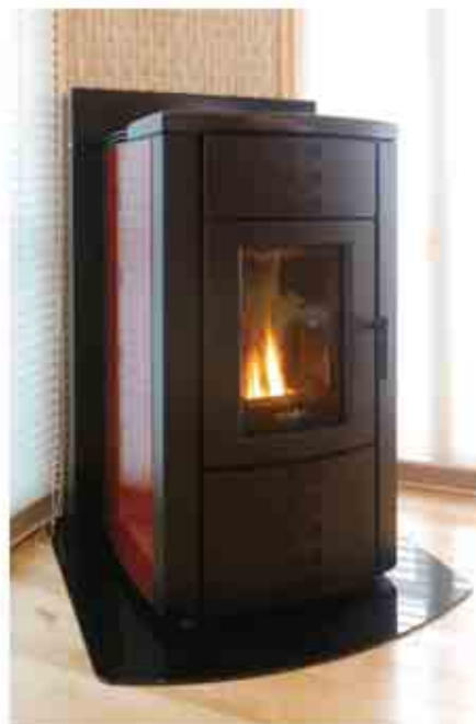
暖房は、ボイラー機能付きペレットストーブで各部屋に温水を循環させています
