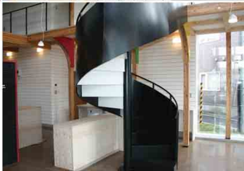
トドマツ板材を突付で貼った内壁、裏にはクラフト紙
