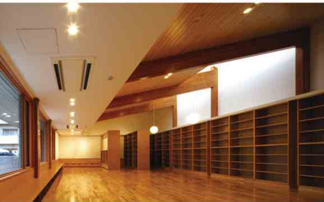
図書室：カラマツ集成材の梁、ナラ材フローリング 天井・腰壁・家具はシナ材
