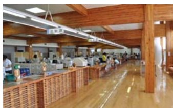
写真 サミットHR工法へのカラマツ集成材の利用例（足寄町役場庁舎）
