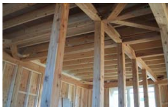
写真 住宅へのカラマツ高温乾燥材の使用
