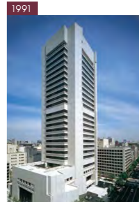
りそな銀行（旧 大和銀行） 本店ビル Risona Bank Headquarters
