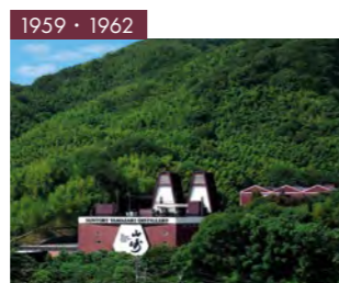
サントリー山崎蒸溜所 事務所棟 （旧製麦場）・貯蔵棟 Suntory Yamazaki Distillery
