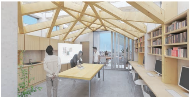
高層階の木耐震方杖（9階オフィス内観）
