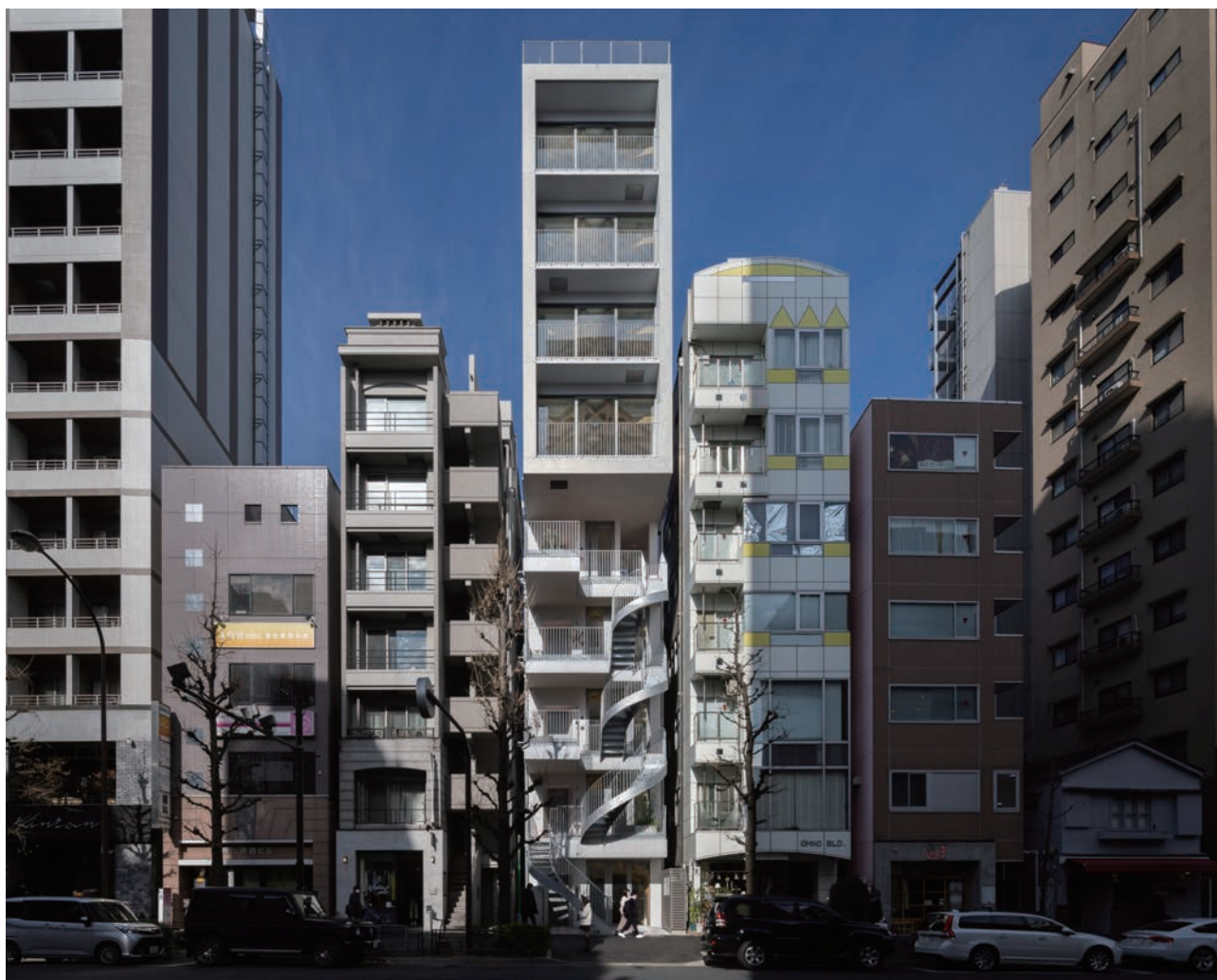
駒沢通り越しに見る南側外観 (画面中央)
