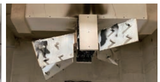
試験体1 燃焼実験後
