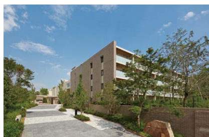
グランクレール世田谷中町(シニアレジデンス / ケアレジデンス) 土地:賃借 定期借地権【期間:2088年7月31日まで(解体期間含む)】
