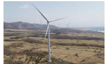
リエネ松前風力発電所
