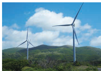
リエネ松前風力発電所
