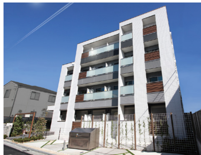
軽量鉄骨造ながら4階建が可能。居室は入居者からのニーズが高い分譲マンションレベルの遮音性能を標準化している
