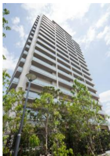
ブランシエラ浦和 (平成21年竣工)
