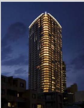
パークコート赤坂 ザタワー 総戸数:463戸 地上43階建 竣工年月:2009年6月
